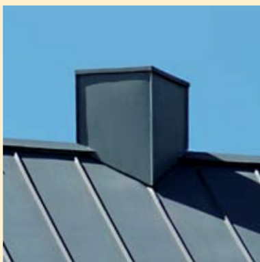
Anvendelsen af tagets materiale som indklædning giver skorstenen en naturlig samhörighed med huset.
